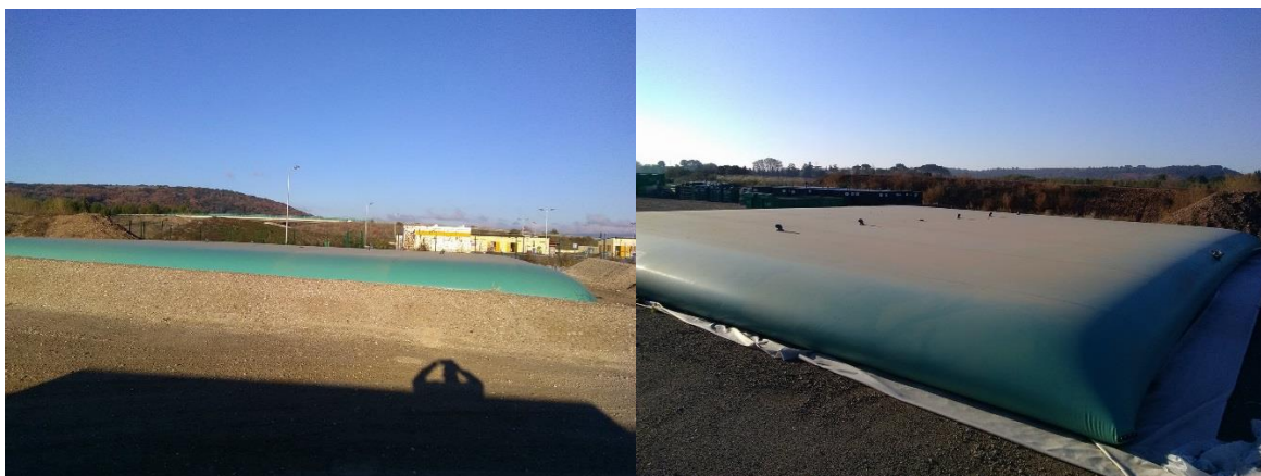
Citerne souple (déchèterie Aspiran)
