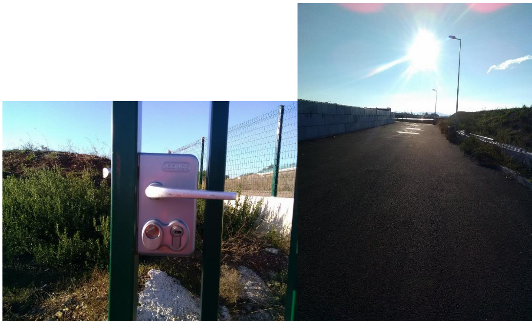
Clé tricoise « accès service de secours ». Voie d'accès vers la déchèterie et vers la citerne.
